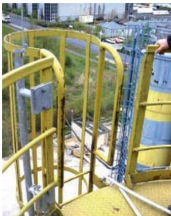
**Abb. 4.1.4:** Der beidseitig vom Rückenschutz montierte Seitenschutz gewährleistet einen sicheren Ein- und Ausstieg von der Steigleiter auf das Dach.
