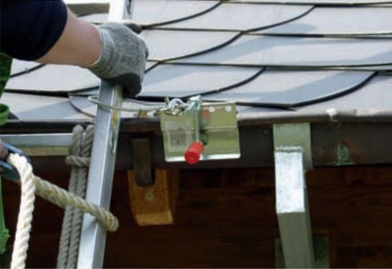
**Abb. 4.3.3:** Anlegeleiter als Zugangsweg zur Dachfläche: Die Leiter wird gegen seitliches Verrutschen durch eine spezielle Haltevorrichtung gesichert.
