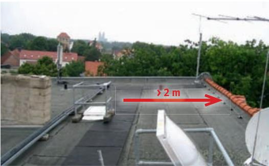
**Abb. 6.0.1:** Auf Dächern mit Neigungen  $\leq 20^\circ$  ist auf Zugangswegen, die einen Abstand von  $> 2$  m zur Absturzkante aufweisen, kein Absturzschutz erforderlich.
