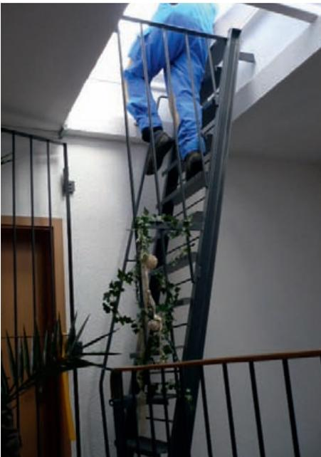
**Abb. 4.4.1:** Zum Schutz vor einem Absturz von der ortsfesten Stufenleiter ins Treppenhaus verfügt die Leiter über ein seitliches Schutzgitter.
