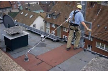
**Abb. 7.5.1.1:** Durch die Position des Anschlagpunktes in ca. 2,5 m Entfernung von der Dachkante ist auch bei max. Einstelllänge des Verbindungsmittels ein Absturz nicht möglich.
