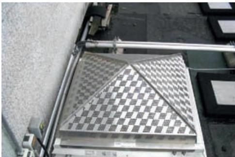
**Abb. 7.3.7:** Sicherung einer Lichtkuppel mit einer Abdeckhaube aus Aluminium. Die Gestaltung der Lichtöffnungen ermöglicht einen gleichmäßigen diffusen Lichteinfall.
