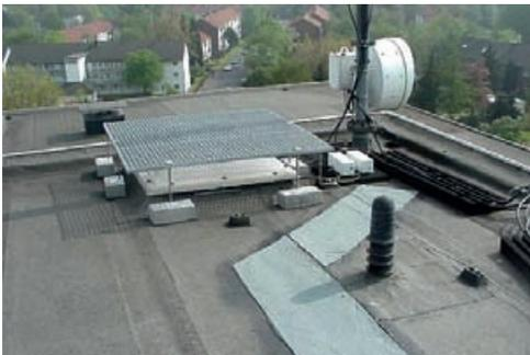
**Abb. 7.3.6:** Die Lichtkuppel im Arbeitsbereich ist durch einen aufgeständerten Gitterrost gesichert. Mögliche Funktionen der Lichtkuppel sind berücksichtigt.
