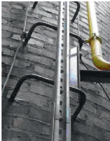
**Abb. 4.1.3:** Steigeisengang älterer Bauart mit nachgerüsteter Steigschutzschiene als Absturzsicherung. Eine sichere Besteigung wird durch Einsatz eines mitlaufenden Auffanggerätes in Verbindung mit einem Auffanggurt nach DIN EN 361 ermöglicht.
