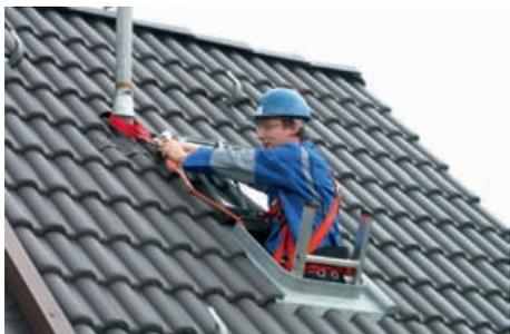
**Abb. 7.5.2.1: Beispiel 1:** Vor dem Aussteigen aus der Dachluke wird mittels Bandschlaufe ein Anschlagpunkt am Dachständer eingerichtet. Das Sicherheitsseil wird mittels Karabinerhaken an der Bandschlaufe befestigt.
