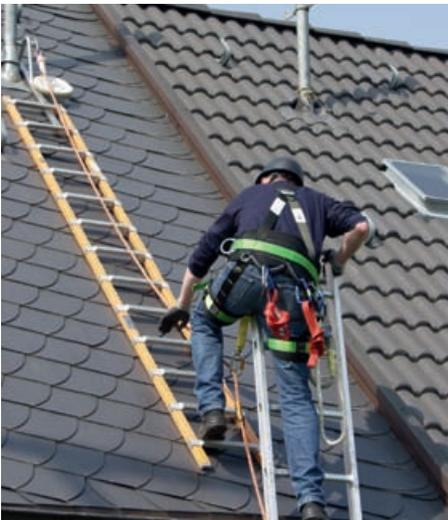
**Abb. 4.3.1:** Anlegeleiter als Zugangsweg zur Dachfläche. Zum Festhalten beim Übersteigen muss die Leiter  $\geq 1$  m über die Dachtraufe hinaus ragen und ist gegen seitliches Verrutschen zu sichern.
