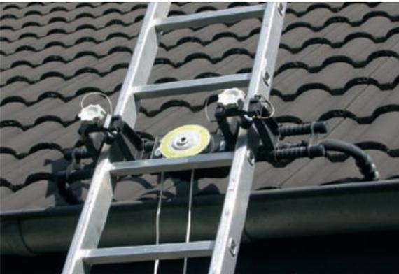
**Abb. 4.3.4:** Anlegeleiter als Zugangsweg zur Dachfläche: Eine justierbare Quertraverse ermöglicht ein unmittelbares Auflegen der Leiter auf die Dachfläche ohne Belastung der Regenrinne. Eine Sicherung gegen seitliches Verschieben ist gegeben.
