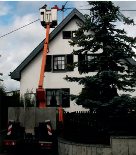
**Abb. 4.2.1:** Arbeiten an einem Dachständer mittels Hubarbeitsbühne
