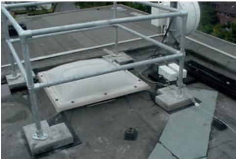
**Abb. 7.3.4:** Die nicht durchsturzsichere Lichtkuppel im Zugang zum Arbeitsbereich an der Antennenanlage ist durch eine Umweh- rung gegen Absturz gesichert.
