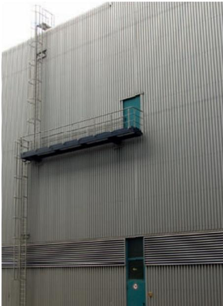
**Abb. 4.1.1:** Steigleiter mit Rückenschutz und einer Absturzhöhe  $> 5$  m
