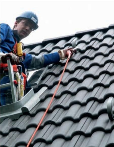
**Abb. 5.3.4:** Der oberhalb des Dachausstieges liegende Sicherheitsdachhaken kann als Anschlagpunkt genutzt werden.
