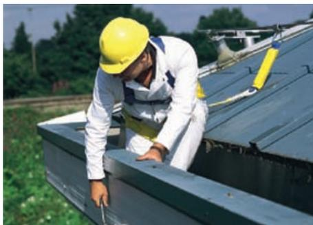
**Abb. 7.5.1.3:** Anschlagseinrichtung mit horizontaler beweglicher Führung in Verbindung mit einem Bandfalldämpfer.
