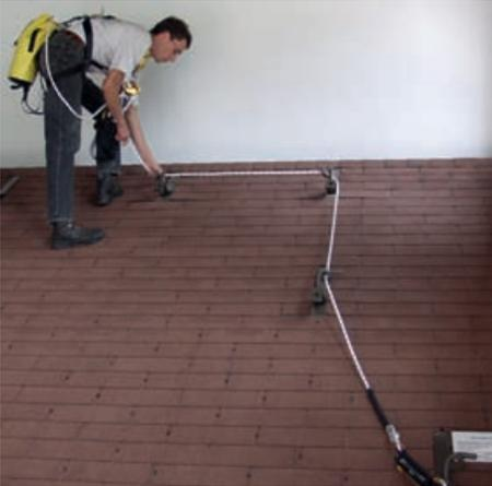
**Abb. 5.3.5: Einsatz einer Dachspirale**
