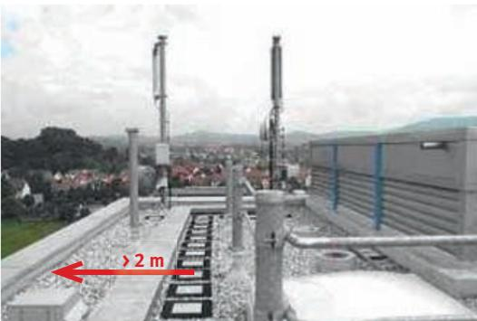
**Abb. 6.0.2:** Der Verkehrsweg ist auf der bekiesten Dachfläche mit Gehwegplatten trittsicher gestaltet und ist min. 2 m von der Dachkante (links) entfernt.
