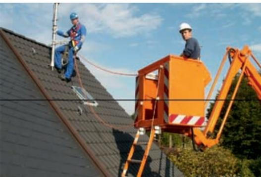
**Abb. 4.2.4:** Eine Sicherung gegen Absturz an der Hubarbeitsbühne ist möglich, wenn der Arbeitskorb über einen Anschlagpunkt nach DIN EN 795 verfügt.
