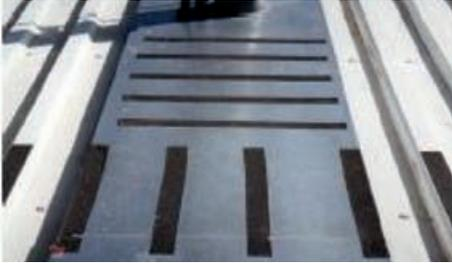
**Abb. 6.1.2:** Beispiel für die Ausstattung einer glatten Dachfläche mit Antirutschstreifen.
